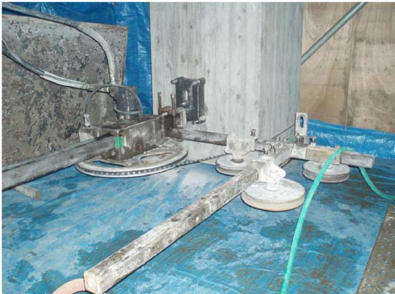
ワイヤーソー柱切断工事
