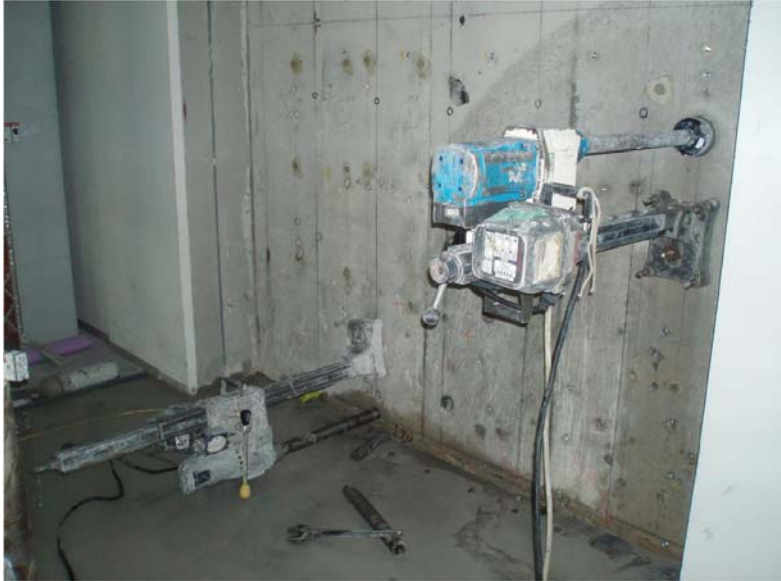
ワイヤーソー工事の パイロット孔明け作業
