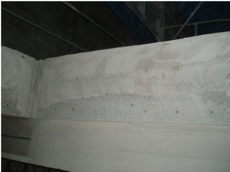
ワイヤーソー工事の切断面
