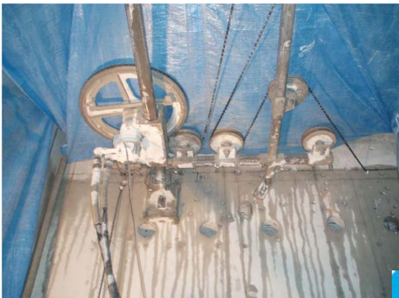
ワイヤーソー壁天端切断状況
