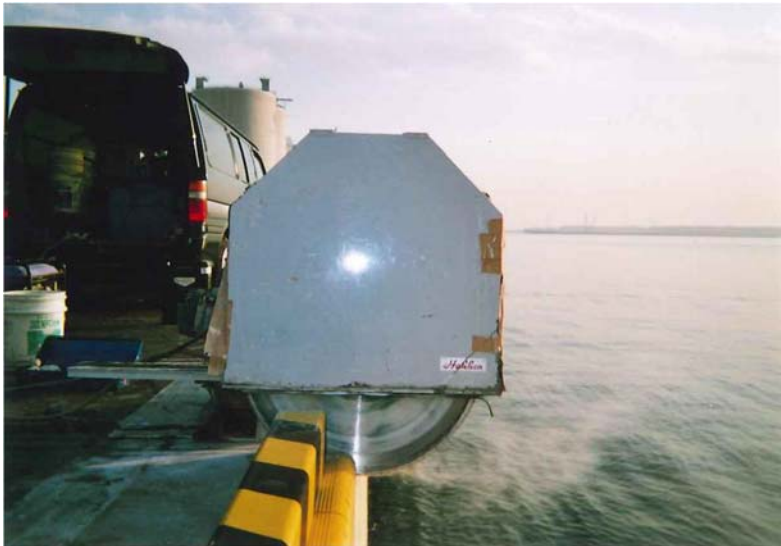
護岸端部ウォールソー切断工事
