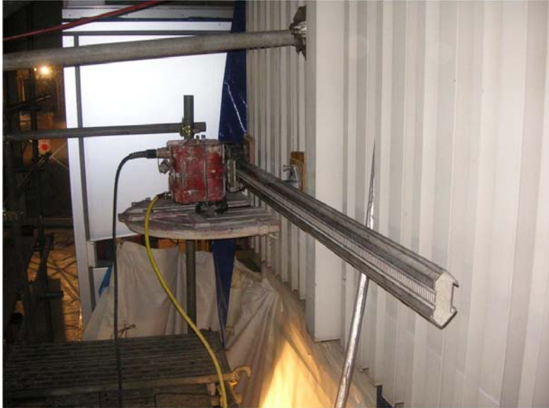
化粧壁ウォールソー切断工事
