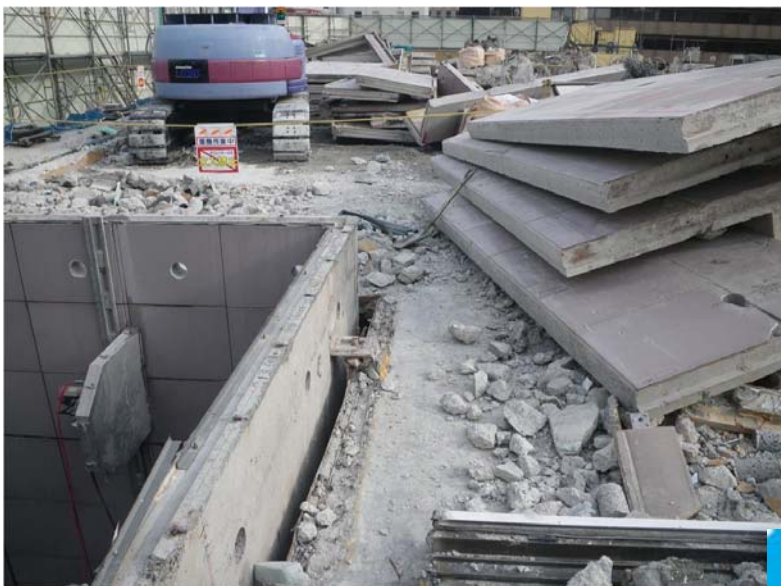
壁撤去ウォールソー工事
