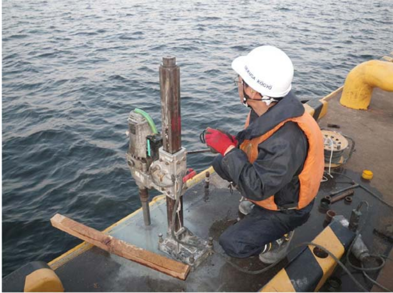
ケミカルアンカー打設用コア抜き
