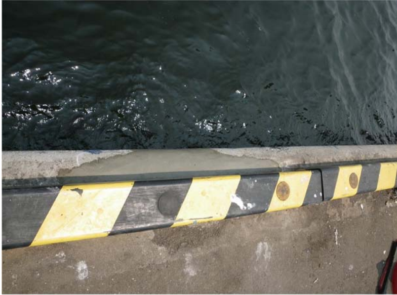
旧車止破損状況
