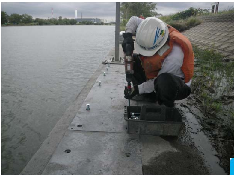
全ネジボルト下向接着工事
